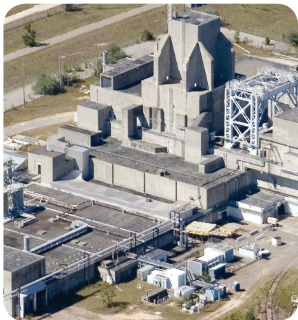
拆除前的核电站
